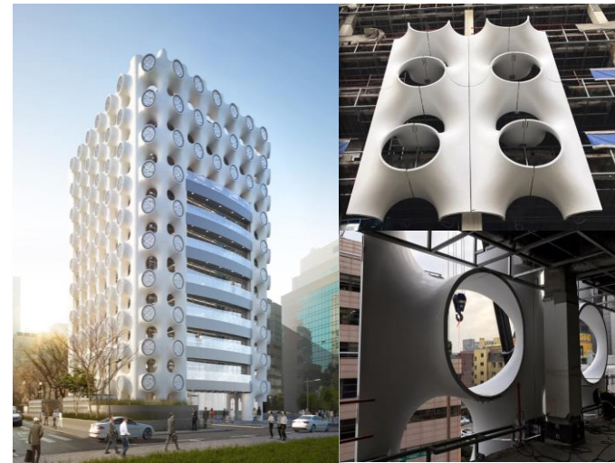
[현장설치 전경 및 개요]
