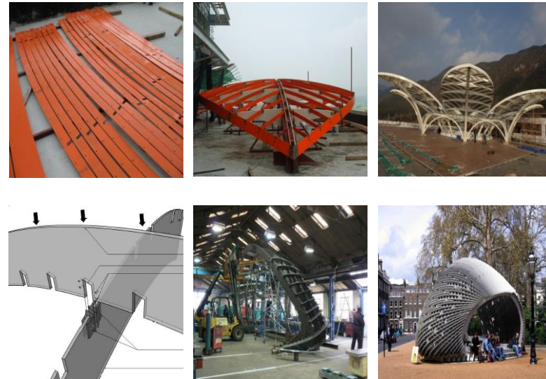
[현장설치 전경 및 제작방법]
